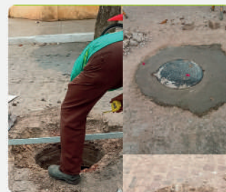
Reparo de bueiros é realizado em diversas localidades do município
