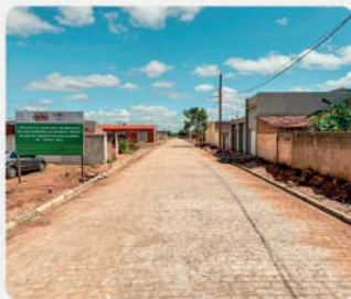
Pavimentação de ruas é realizada em diversos pontos da cidade
