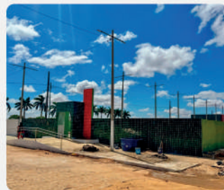
Manutenção no cemitério público garante melhorias na estrutura
