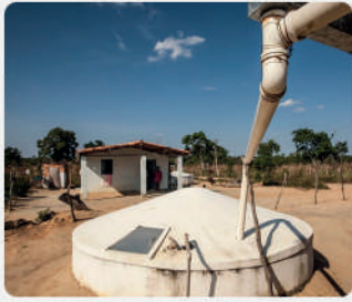
Construção de cisternas beneficia agricultores do município
