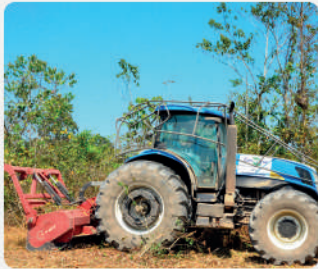
Manutenção das estradas vicinais garante melhor trafegabilidade na zona rural
